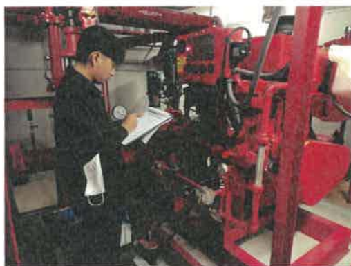
ตรวจสอบระบบป้องกันและแจ้งเตือนอัคคีภัย
