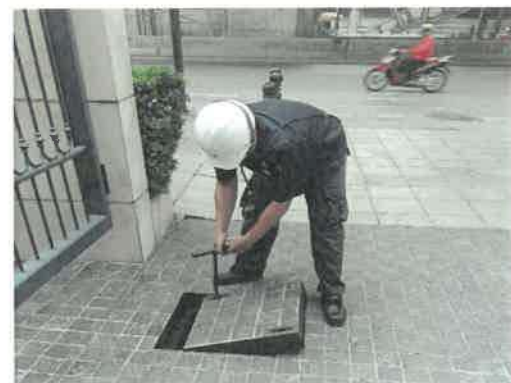
เจ้าหน้าที่ตรวจสอบปริมาณไขมันและตะกอน
